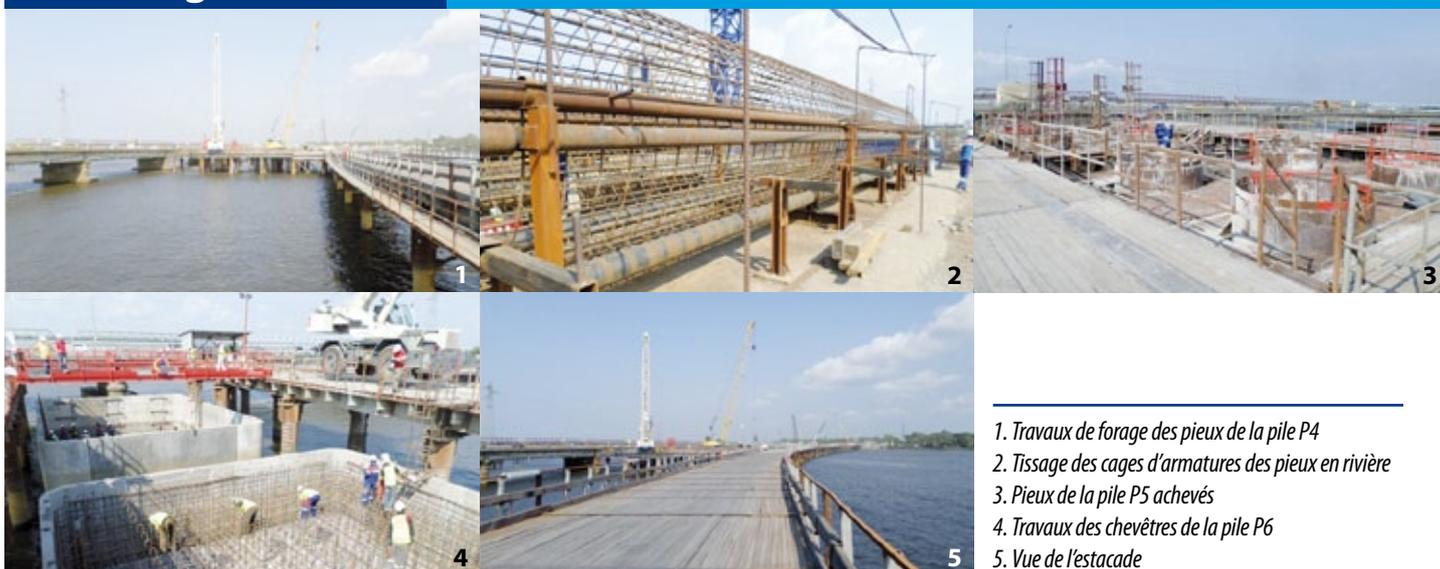
1. Travaux de forage des pieux de la pile P4
