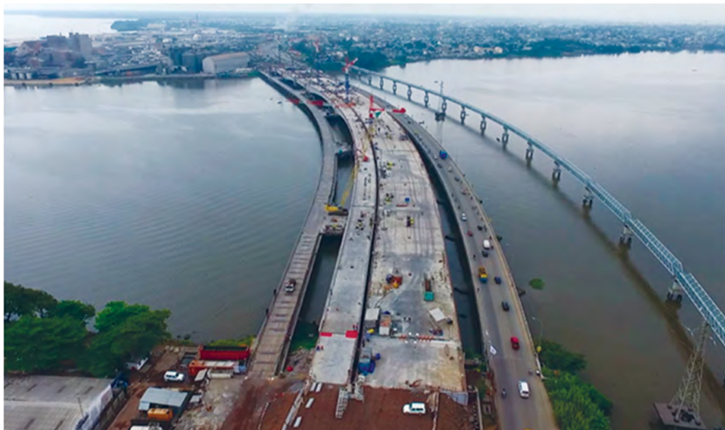
Les travaux de gros-œuvre du second pont sur le Wouri sont terminés
